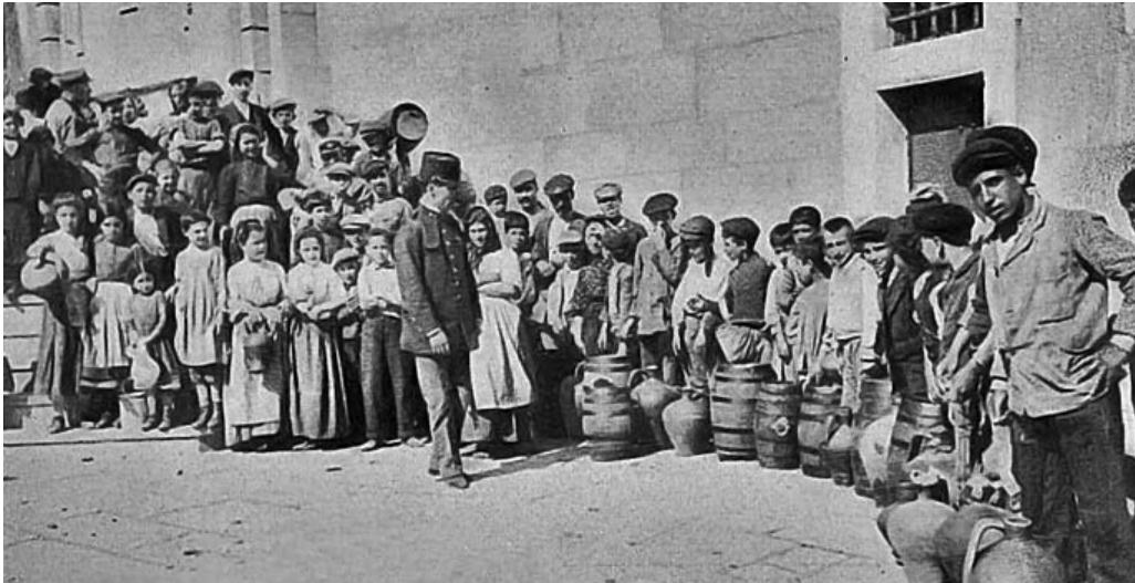
Ilustração 9 A falta de água em Lisboa. "À vez no chafariz da Rua do Século" – Ilustração Portuguesa (1913), n.º 385, p. 29.
